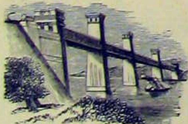
Britannia Tubular Bridge, p. 1422.
